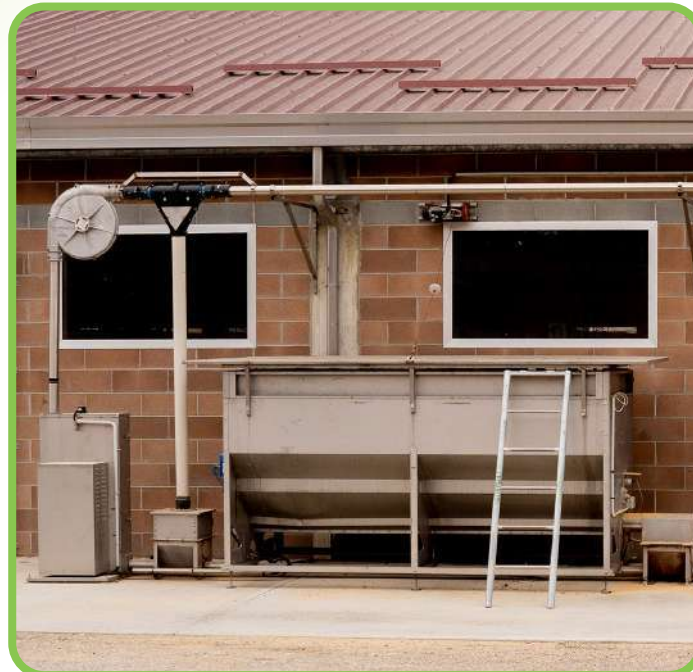
TOLVA DE CARGA
